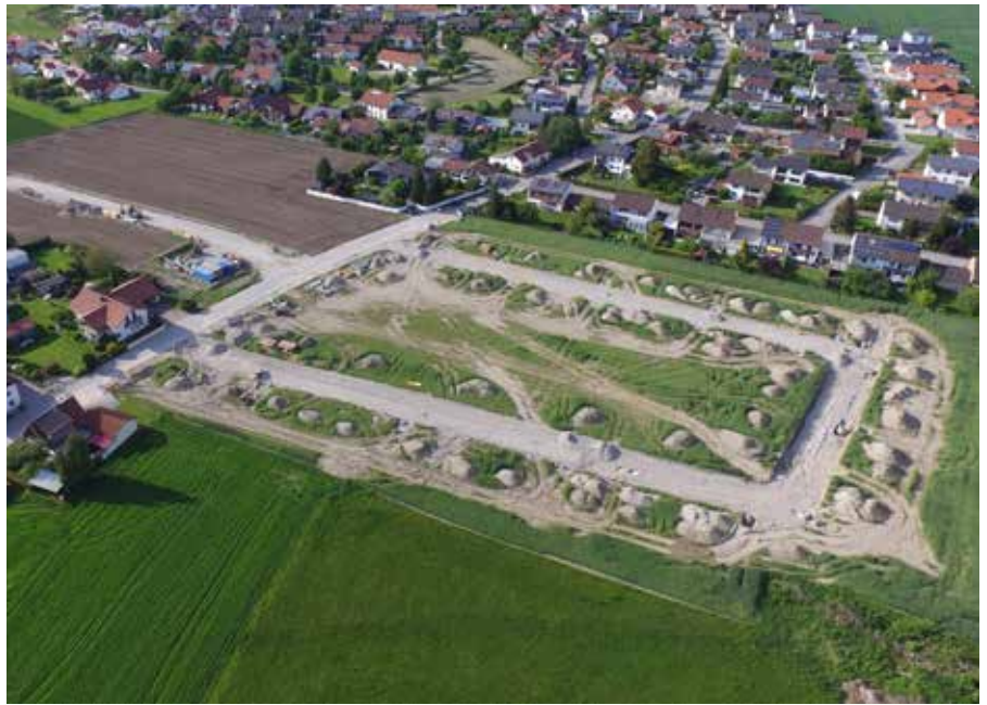
Das Luftbild zeigt das Baugebiet „Isarstraße“
