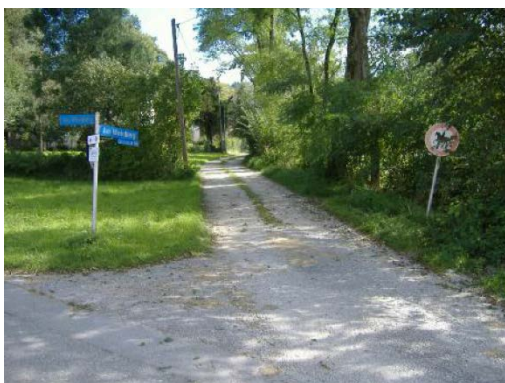
Bestand 2010 - Station B_0+000
