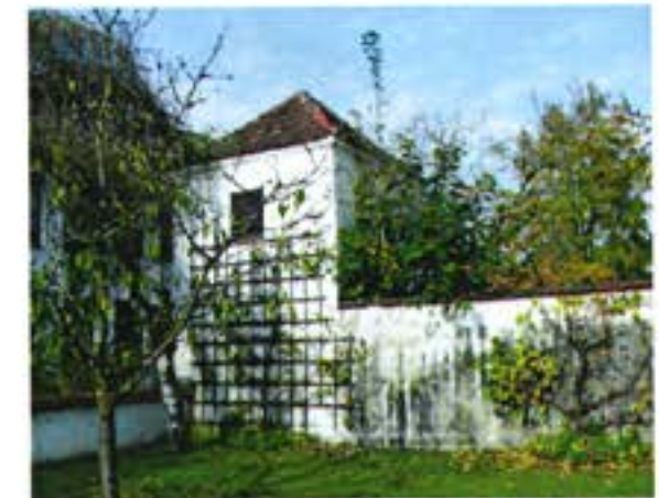
Pavillion mit Umfassungsmauer, ehem. Pfarrhof
